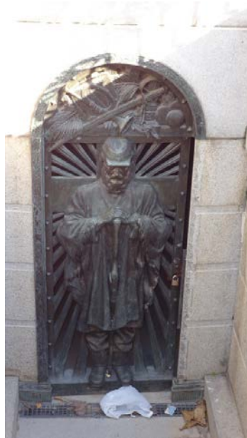
Fig. 4 – Figura de soldado da Infantaria do Exército, o guardião da cripta. Infelizmente no dia da visita ao local o estado de conservação do monumento era lastimável. A presença de lixo na entrada da cripta revela o abandono do espaço e a impossibilidade de visitação do mesmo pelo público em geral. (Acervo Pessoal)
